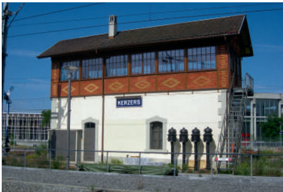
Das 1901 erbaute und 1928 erweiterte Stellwerkgebäude. Die erhöhte Lage des Stellraums war für die Überwachung der Gleisanlage nötig und der massiv gemauerte Sockel erlaubte die Unterbringung des Spannwerks.
