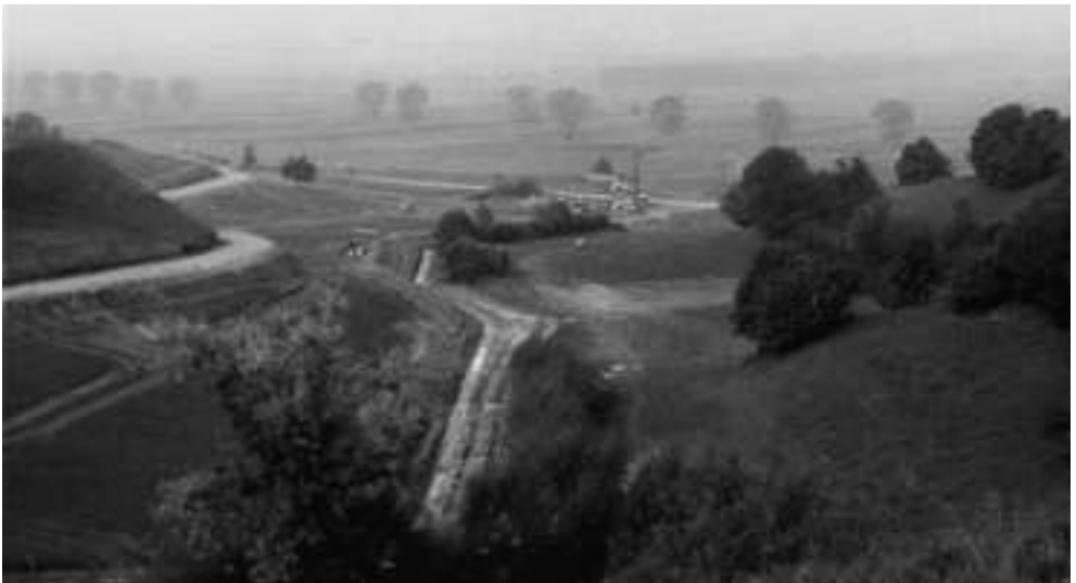
Höll nach Beginn der Arbeiten, links die Kanzel; Stand Oktober 1979.
